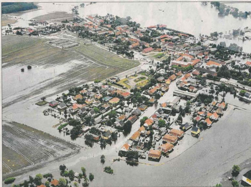
Nach dem Deichbruch war Fischbeck zu großen Teilen überflutet, viele Einwohner haben alles verloren.
