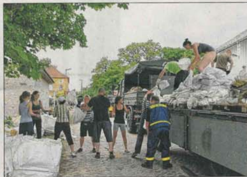
Sandsäcke von überall her wurden in Jerichow angeliefert, abgeladen und in Bigbags „eingezählt“, um diese dann ebenfalls mit den Hubschraubern zur Deichbruchstelle bringen zu können.
