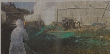
Ein Helfer sprüht im April 2011 eine Schutzlösung in die Ruine.
