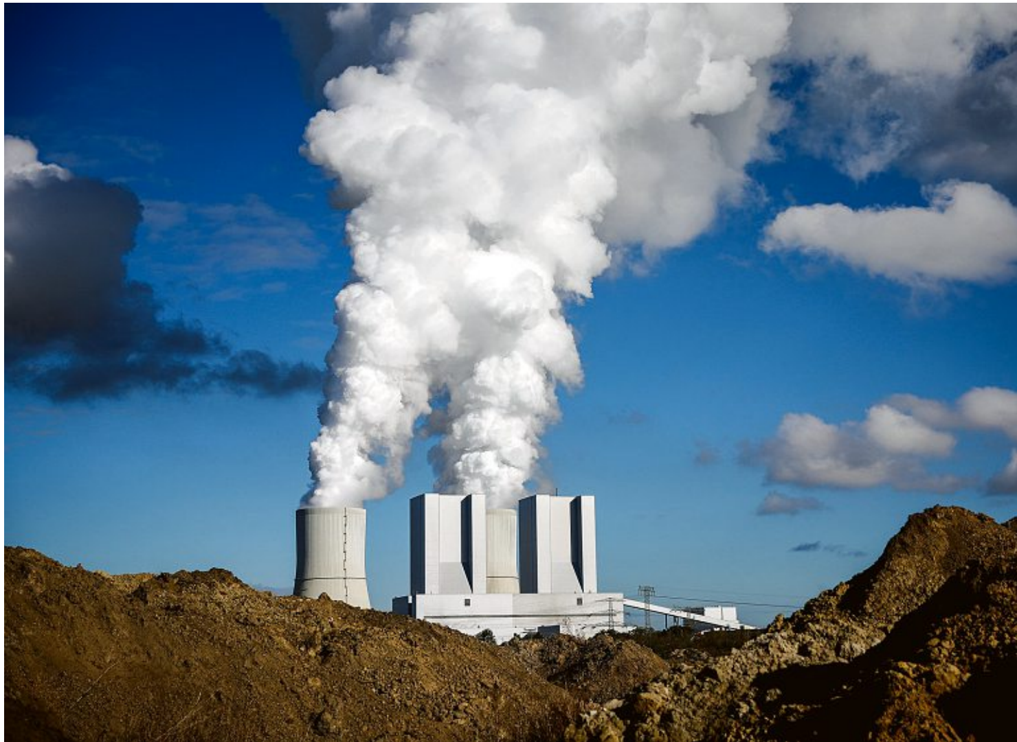
Sachsen, Braunkohlekraftwerk Lippendorf: 2021 war es das Kraftwerk mit den neunthöchsten Treibhausgasemissionen in Europa.
